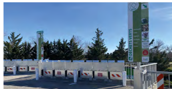
La déchèterie de Tarascon après les travaux de mise en conformité.
